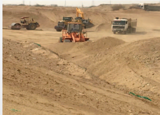
البدء في تنفيذ إنشاء خلية المخلفات والهدم بمصفاة أرامكو بجازان
